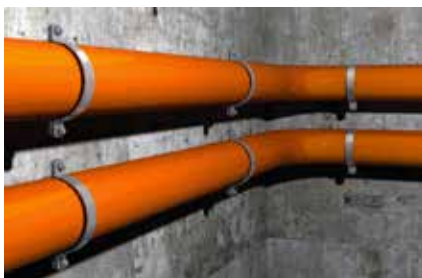
Montaggio di tubazione acque di scarico
