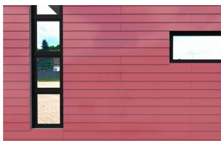
Sigillatura di serramenti.
