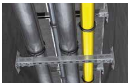
Installazione tubazioni su via di fuga
